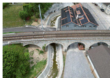
Der Feldbach wurde hochwassersicher ausgebaut.
