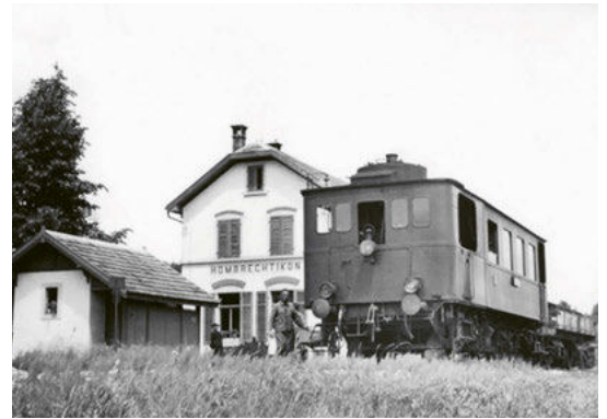
Das Bild zeigt die UeBB in Hombrechtikon vor der Ablösung durch die VZO.
