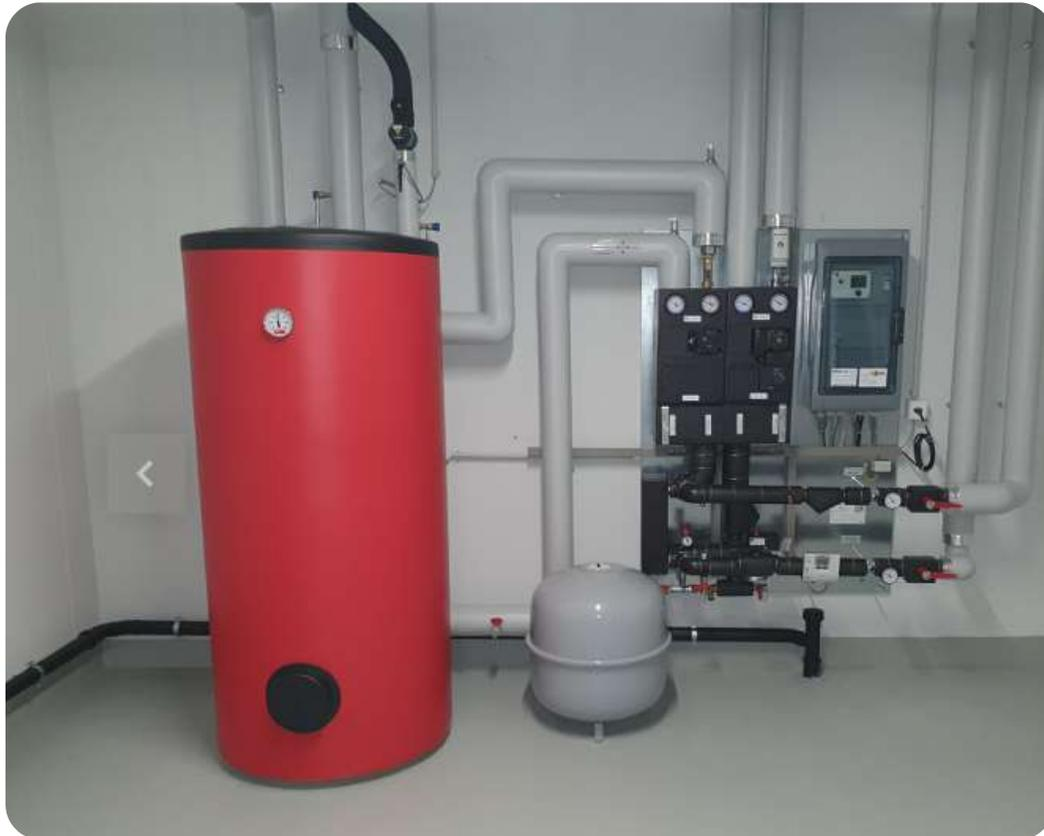
Der bisherige Heizkessel wird durch eine kompakte Wärmeübergabestation ausgetauscht. An den Anlagen für die Wärmeverteilung – etwa an der Umwälzpumpe und den Radiatoren – braucht es keine oder nur geringe Anpassungen. Teilweise macht es Sinn, diese sekundärseitigen Installationen gleichzeitig auf den neusten Stand zu bringen. Wir beraten Sie gerne dabei. Falls Sie bisher über einen Öltank verfügen, können Sie diesen entsorgen lassen und gewinnen freien Platz.
