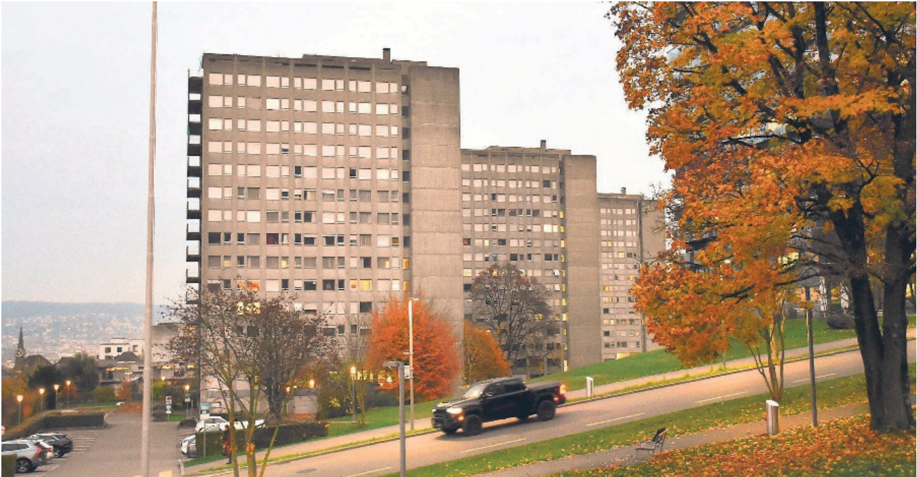
Das Herbstlicht lässt die drei Triemli-Personalhäuser fast schön wirken (v. l.): Haus C, Haus B und Haus A werden zwischengenutzt. BILD PASCAL TURIN
