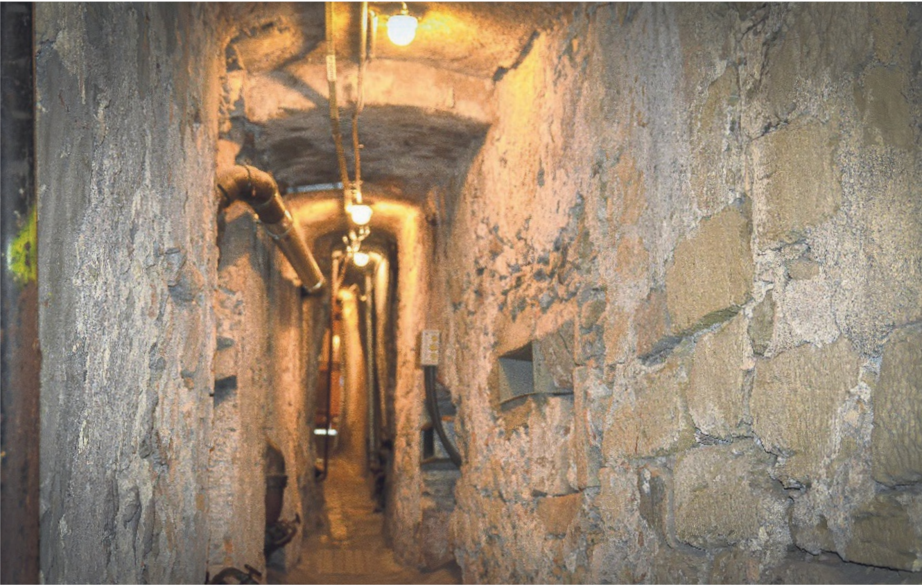
Beklemmend eng: An manchen Stellen ist der Ehgraben, Zürichs einstige öffentliche Kloake, gerade einmal 40 Zentimeter breit.
