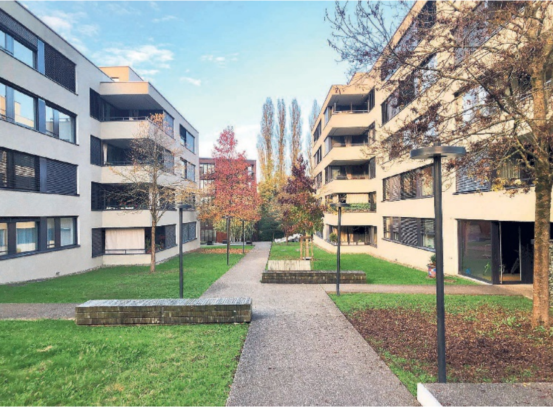
Siedlungen «Am Katzenbach» der Genossenschaft Glattal: eine frühe Etappe im Vorder-, eine späte im Hintergrund. BILDER TOH
