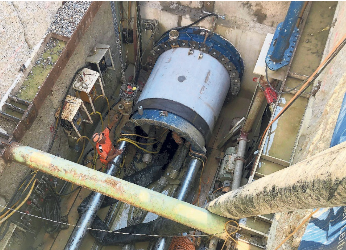
Das erste Bauwerk von CoolCity: Der kleine Microtunnel schliesst den Seewasserverbund Fraumünster an CoolCity an. BILDER TOBIAS HOFFMANN
