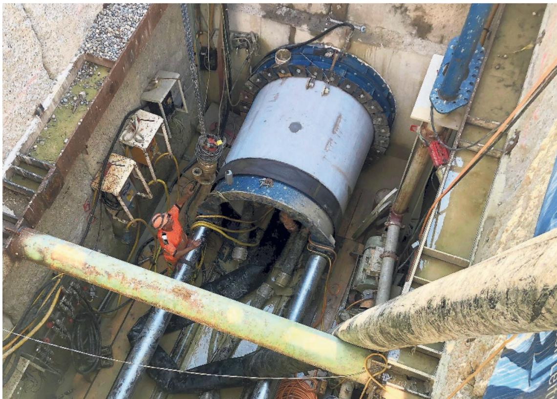
Das erste Bauwerk von CoolCity: Der kleine Microtunnel schliesst den Seewasserverbund Fraumünster an CoolCity an.
