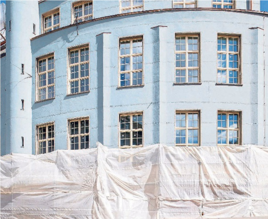
Frisch renoviert: frühere Telefonzentrale an der Füsslistrasse. BILD AMT FÜR STÄDTEBAU, JULIET HALLER
