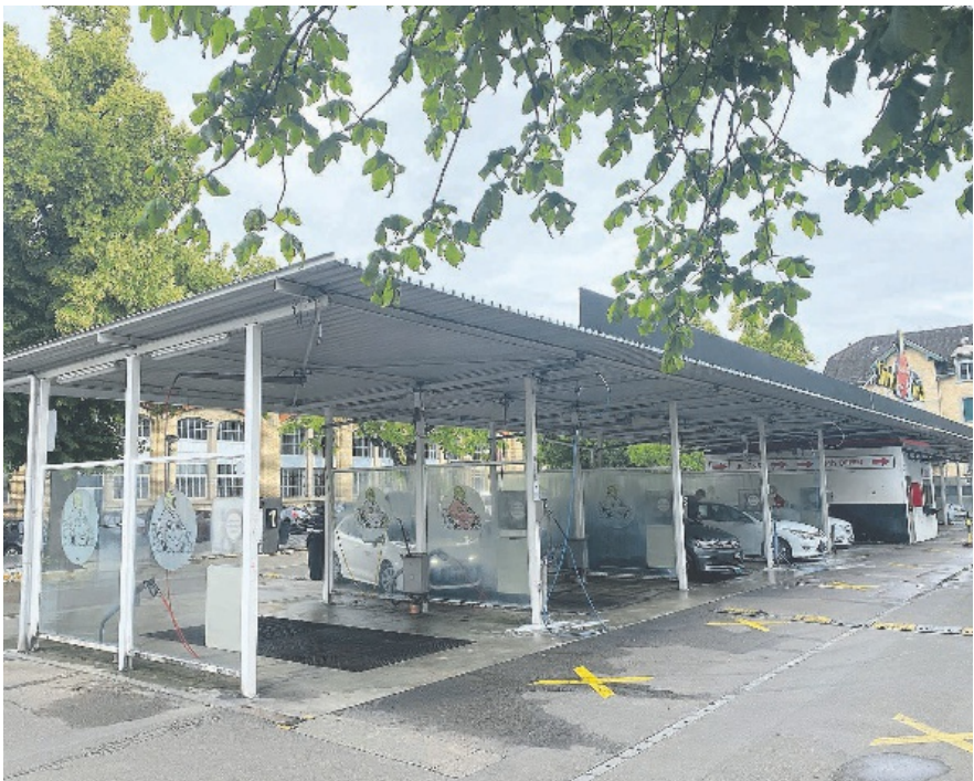
Abgebrochen wird die beliebte Stützliwösch beim Letzipark.
