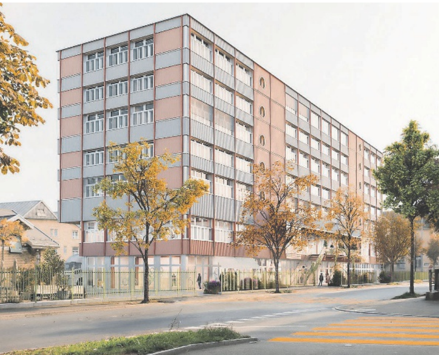
Der Neubau soll viel Recyclingmaterial enthalten, auch Eisenbahnschienen.
