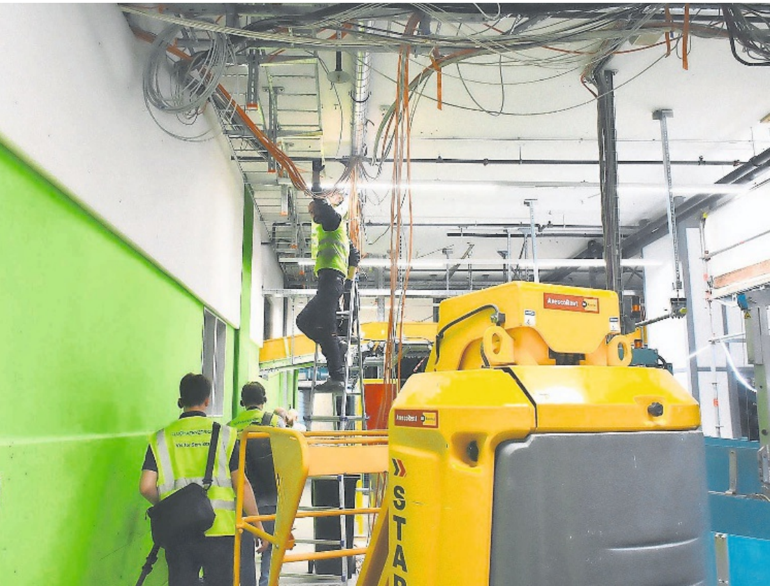
Die Bauarbeiten für die neue Gepäcksortieranlage werden während dem laufenden Betrieb durchgeführt.
