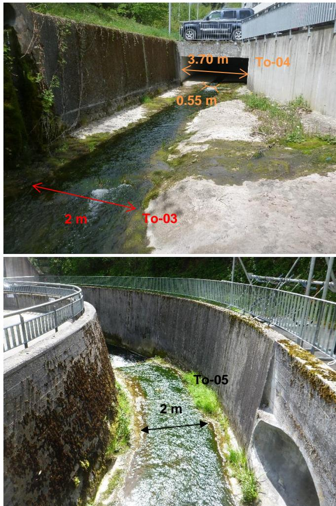
Abbildung 29: Breitenangaben für den offenen Abschnitt To-03 und den eingedolten Abschnitt To-04 des Tobelbachs, Blick gegen Fließrichtung (oben). Breitenangabe für den offenen Abschnitt To-05 des Tobelbachs, Blick in Fließrichtung (unten).
