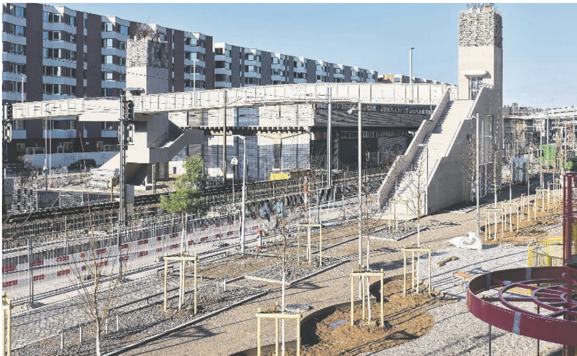
Bei der Passerelle des Schulhauses Allmend sorgen sickerungsfähige Flächen und Bäume für Kühlung.
