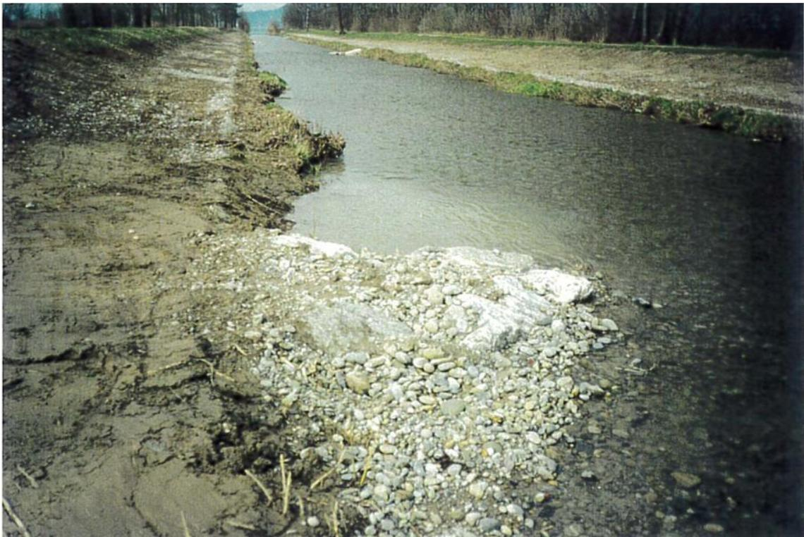
Abbildung 2: Buhne unterhalb der Fussgängerbrücke, Fotodokumentation Verbauung Aabach Schmerikon Abschnitt SBB bis Mündung, 1997/98 (OEPLAN 1997).
